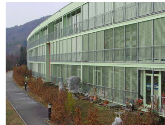
Abb. 6.4: Die nach Süden gerichtete Fassade. Im Erdgeschoß haben die Wohnungen einen direkten Ausgang (hier rechts vorne) zu ihren Gartenflächen
